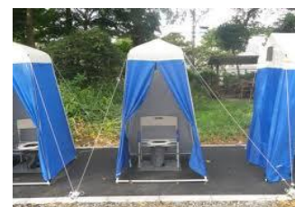
マンホールトイレ
